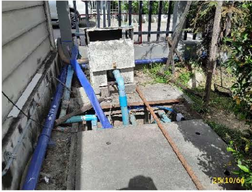
บ่อกักน้ำสุดท้ายก่อนระบายลงรางสาธารณะ
